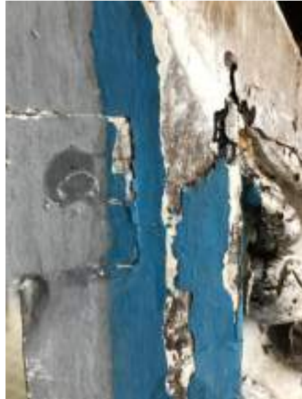
Détail du repaint après nettoyage
