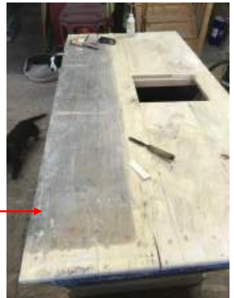
05/03/2021 : La reprise du plateau de l'autel est terminée.
